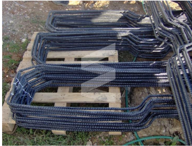
Şekil 1.2 Çeşitli Açılarda Bükülmüş Donatı Telleri
