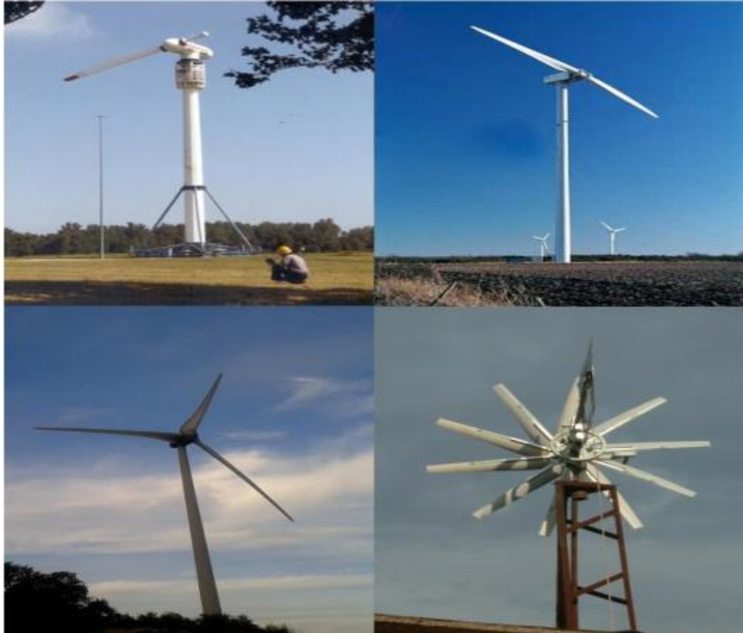
Şekil 2.1 Rüzgarı Önden ve Arkadan Alan Yatay Eksenli Türbin Tasarımları
